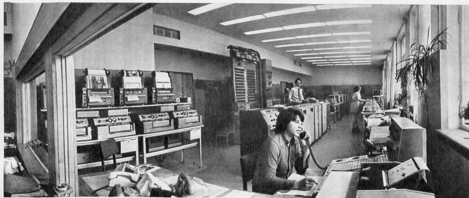
Узел фототелеграфной связи оснащен современным приемо-передающим электронным оборудованием
